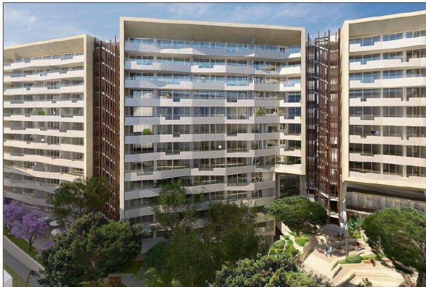
Le chantier du Grand Ida vient de démarrer.
